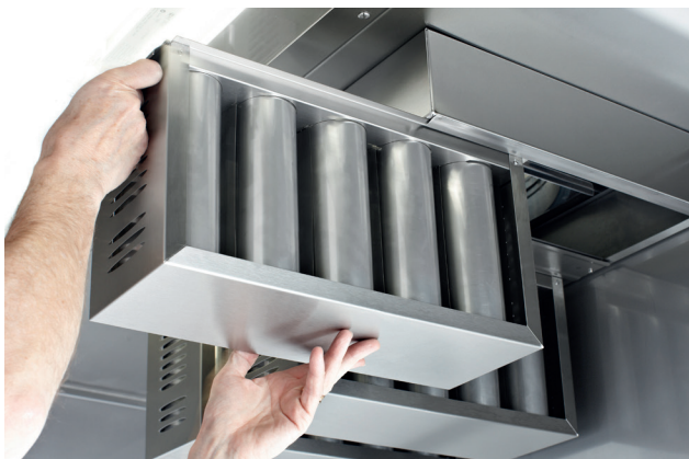
Filterkassetten skjuts in i filterhuset
